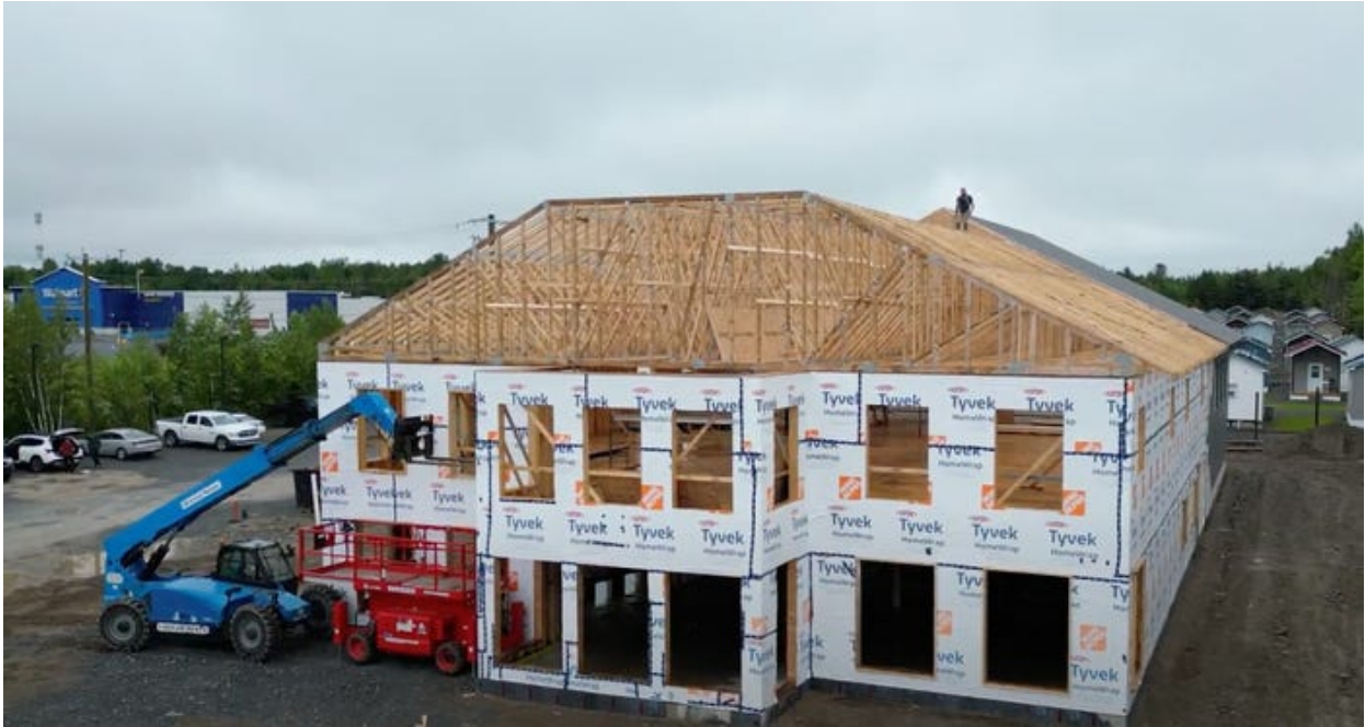
Das Sozialunternehmenszentrum im Bau.
